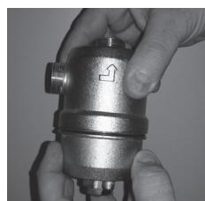
Riavvitare il vaso inferiore al vaso superiore controllando che la guarnizione di tenuta sia correttamente posizionata. Dopo aver fatto circolare il prodotto per 30 minuti analizzare con apposito Kit Molibdeno, la quantità di prodotto entrato in soluzione. Verificare che la concentrazione dei Molibdati non sia inferiore ai 180 mg/l.
